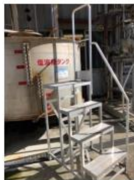
作業ステップへの手すり設置
